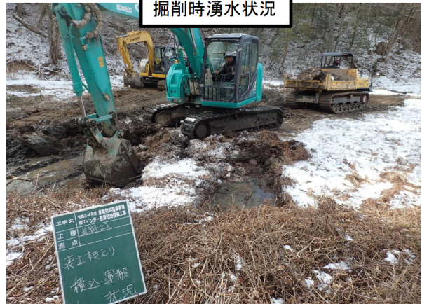
掘削時湧水状況
