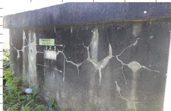
天竜峡配水池(撮影R2劣化度調査より)
