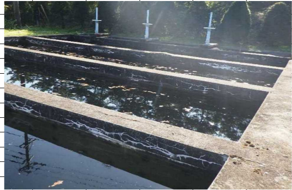
風越貯水池(撮影R2劣化度調査より)
