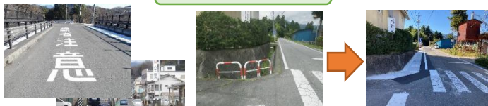
通学路の側溝に蓋をし、歩行空間を確保
