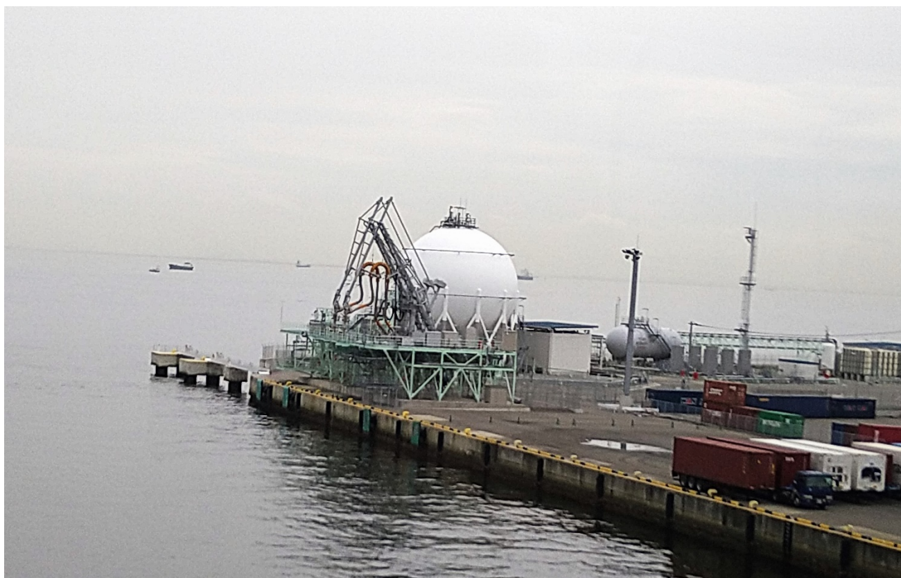
船着き場（連結ホースと貯蔵タンク）
