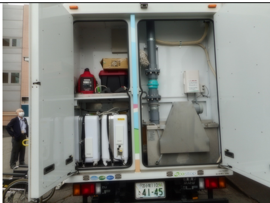
各種装備品 発電機、蓄電池、太陽光パネル 内部 エアコン、折り畳み式ベット
