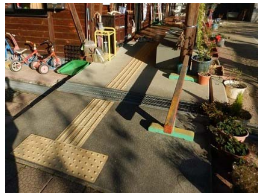
段差なし (スロープ設置)
