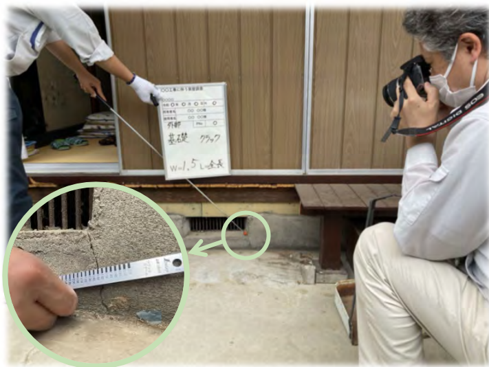
外壁・基礎調査
