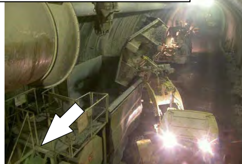
ベルトコンベアで運搬
