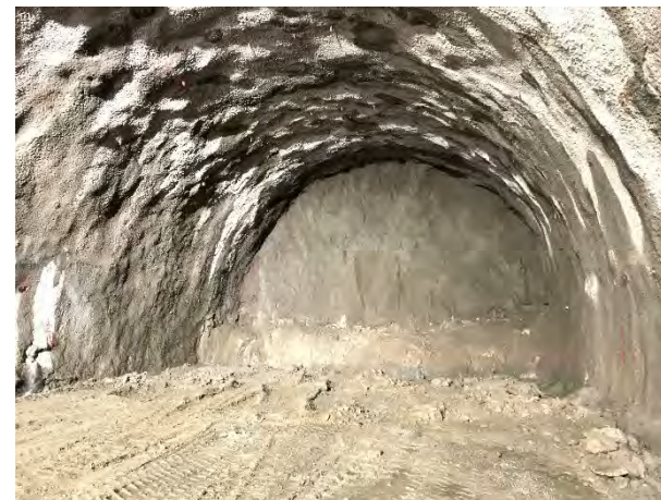
② 照度200ルクスの確保 (中央アルプストンネル(松川)の例)
