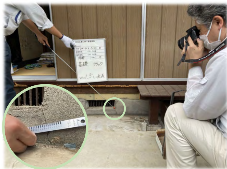
家屋調査状況例
