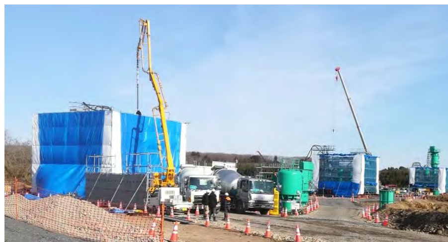
⑥橋脚部コンクリート打設
