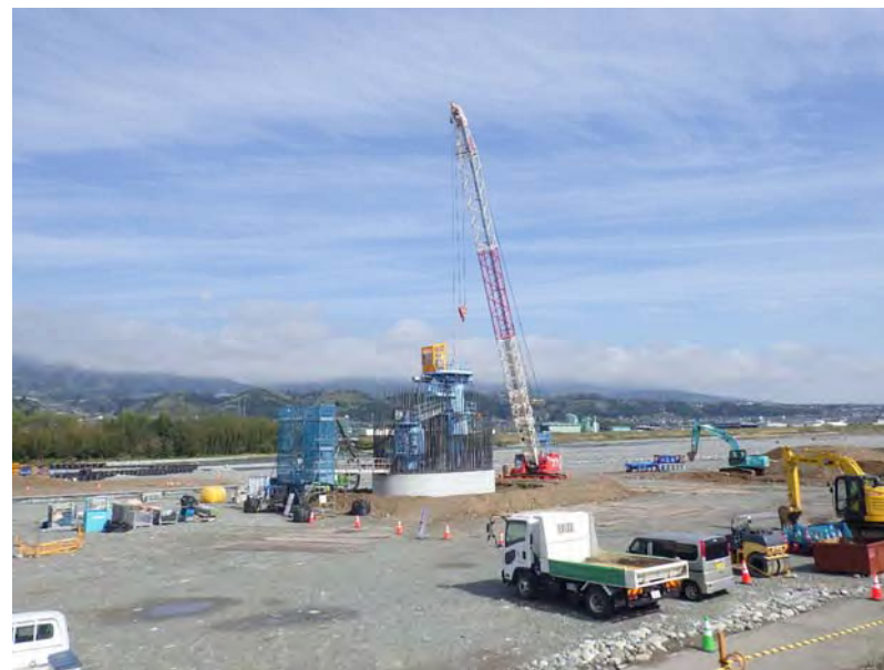
ニューマチックケーソン工法施工例
