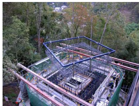
⑤橋脚部鉄筋組立
