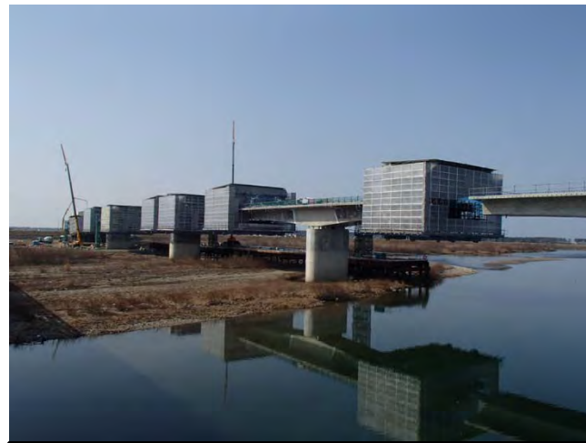
③張出し架設
