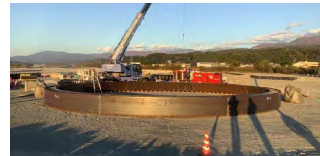
①作業室構築
