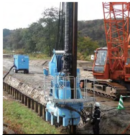
① 鋼矢板打込み
