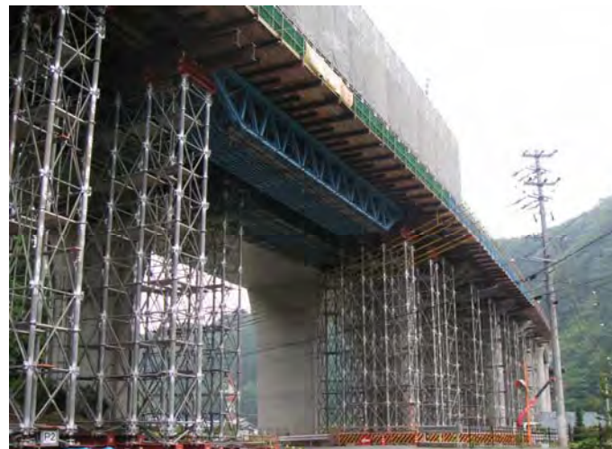
①支柱式支保工、②仮設梁設置
