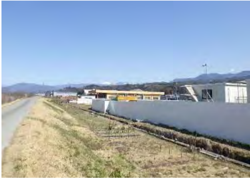
仮囲いの設置
