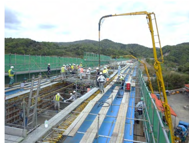
④上部工コンクリート打設
