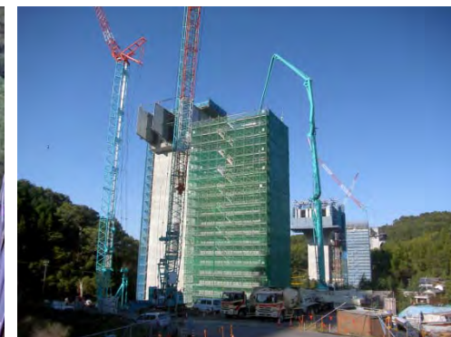
⑥橋脚部コンクリート打設
