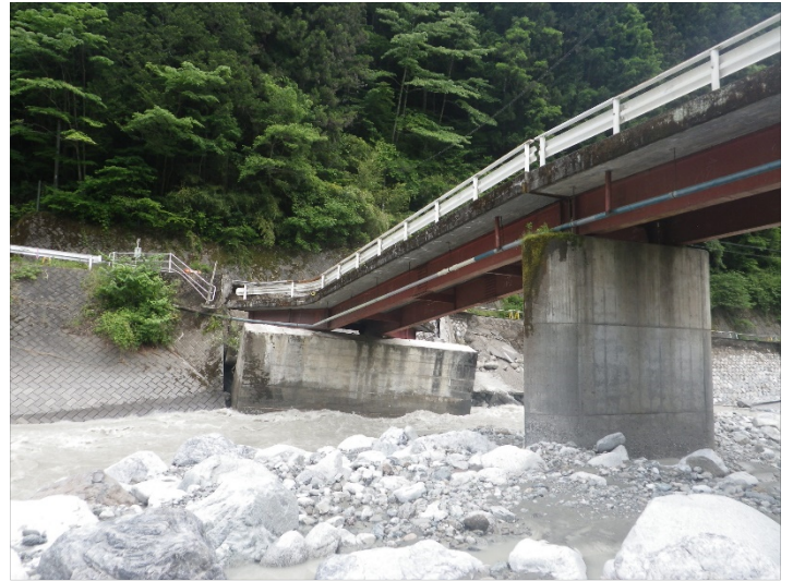
【水道施設】市道南信濃 127 号線 八日市場橋（南信濃）
