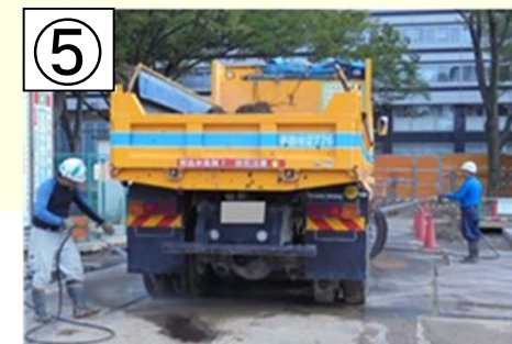
タイヤ洗浄の状況
