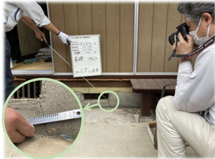
外壁・基礎調査
