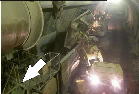
ベルトコンベアで運搬
