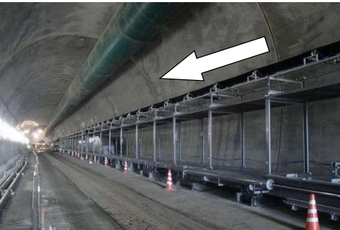
ベルトコンベアに乗せて外まで運び出す
