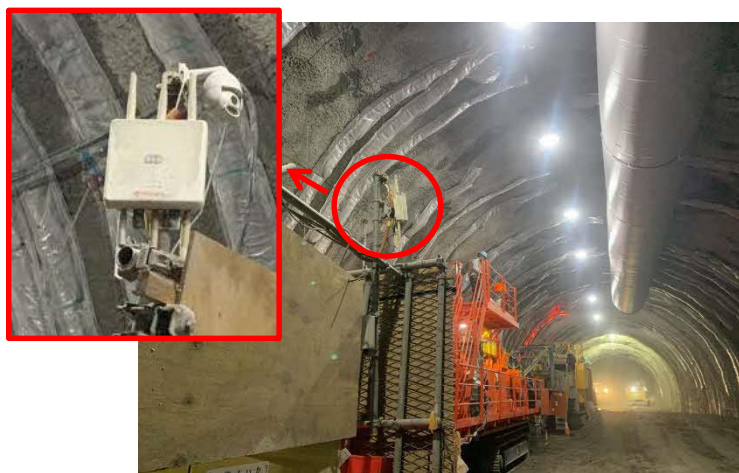
① ビデオカメラの設置 (中央アルプストンネル(松川)の例)
