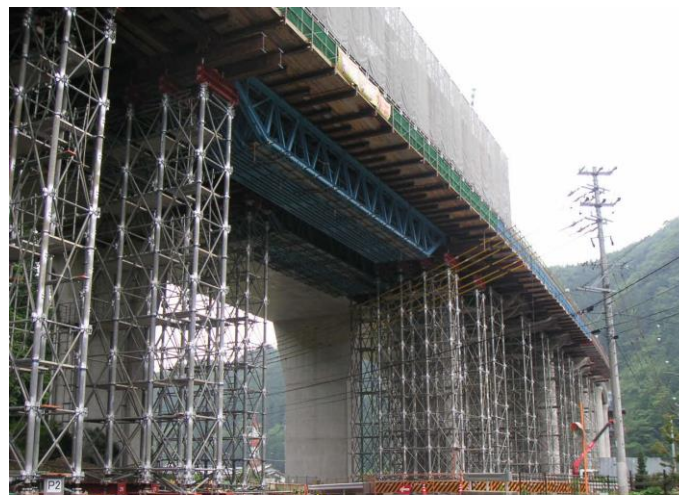
①支柱式支保工、②仮設梁設置
