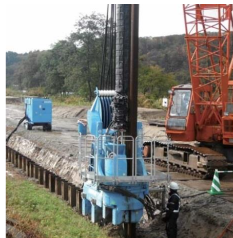
① 鋼矢板打込み
