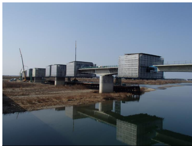
③張出し架設
