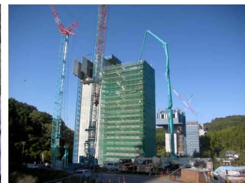
⑥橋脚部コンクリート打設
