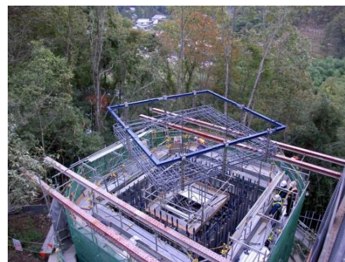
⑤橋脚部鉄筋組立
