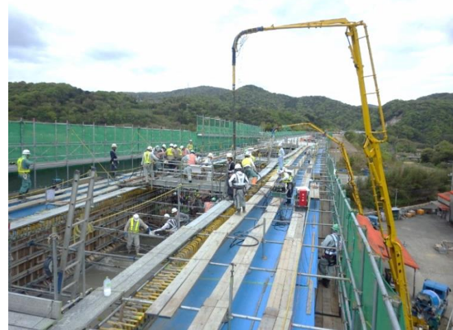
④上部工コンクリート打設
