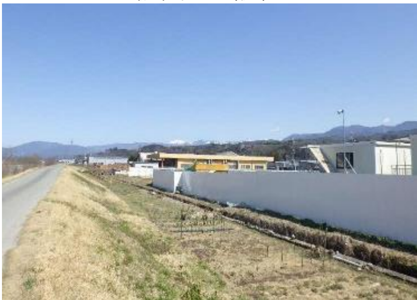
仮囲いの設置
