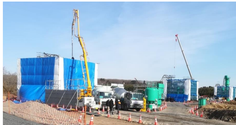
⑥橋脚部コンクリート打設
