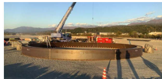
①作業室構築
