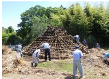
上久堅地区との協働による 縄文時代復元家屋の茅葺撤去
