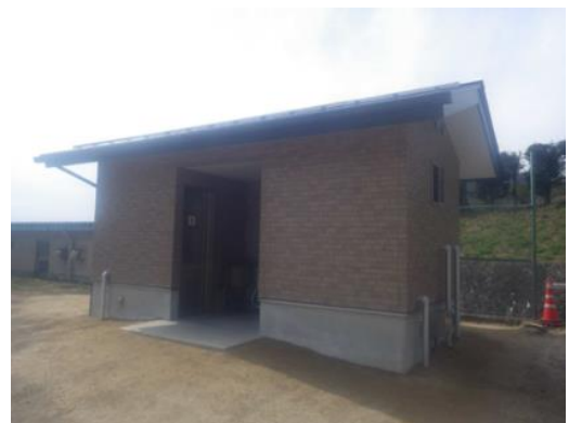
旭ヶ丘中学校屋外トイレ改築工事 （移転新築）
