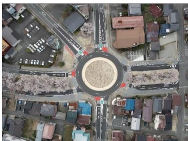
桜並木 吾妻町環状交差点 改良工事
