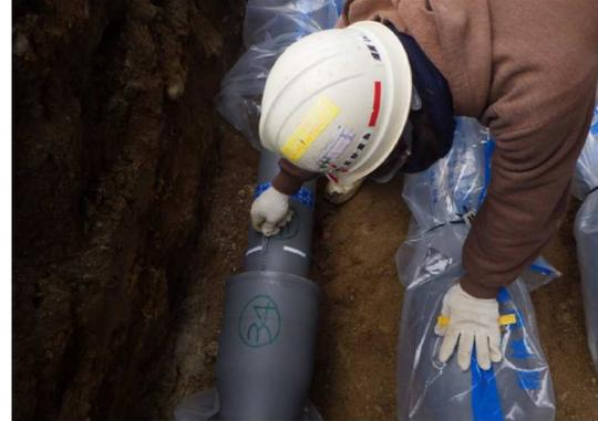
既存管は昭和 40 年に布設した鑄鉄管→更新管は耐震仕様のダクタイル鑄鉄管で 100 年使用が可能です。
