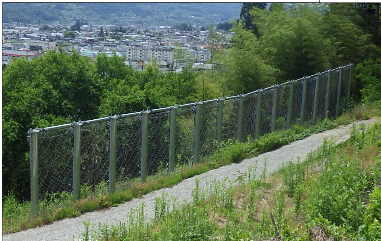
斜面对策工 崩壊土砂防止柵工完成イメージ
