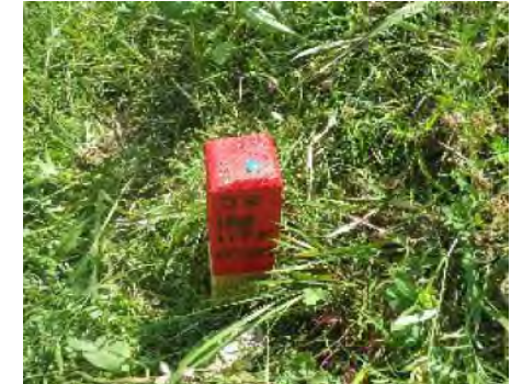
中心杭設置例 (杭)
