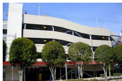
●拠点型駐車場
