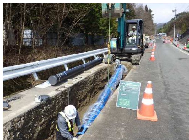
送水管布設工事【上黒田配水池～上郷第1配水池】 （令和元年度布設完了）
