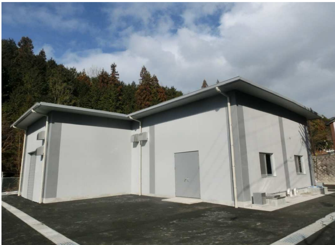
※砂払浄水場から野底浄水場へのバックアップ機能を担う今宮中継ポンプ場（平成31年3月完成）
