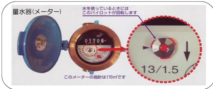
一般の家庭でもっとも多く使われている口径13ミリの水道の量水器（メーター）です。ふたを開けると、指針が数字で表示されています。この水量を表す数字の単位は立方メートル(m<sup>3</sup>)です。
