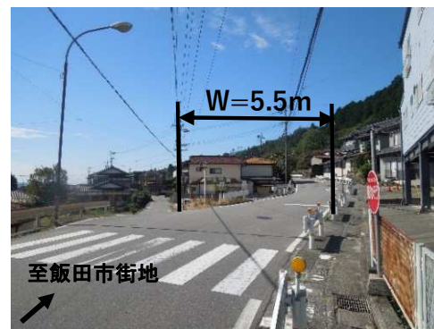
ガードレールによる歩車分離
