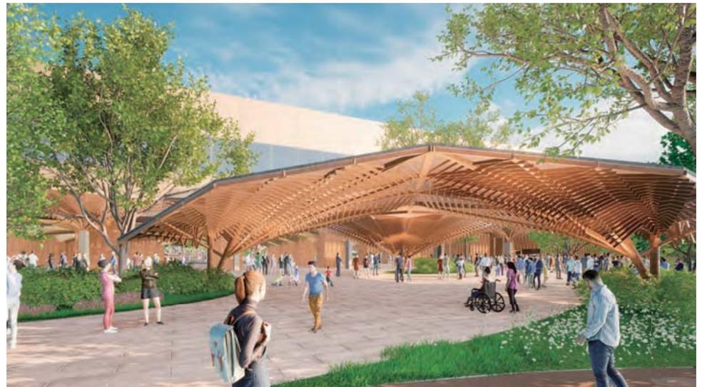
大屋根の材料は、地元材を中心に豊富な森林資源を活用し、集成材ではなくできるだけ手を加えない無垢材のままでの使用が検討されています。地域林業の状況によって、入手しやすくメンテナンスしやすい樹種を選びます。
