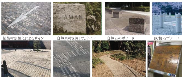
舗装材張替えによるサイン 自然素材を用いたサイン 自然石のボラード RC擬石ボラード 自然石の舗装材 防滑仕様の点字ブロック 景観になじむ防滑仕様のスロープ 音声触知式案内板
