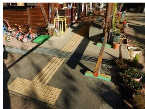
段差なし（スロープ設置）
