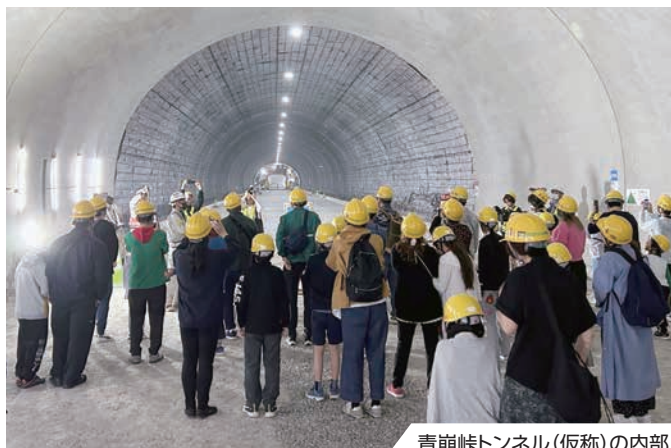
青崩峠トンネル(仮称)の内部
