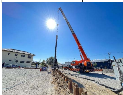
① 鋼矢板打込み
