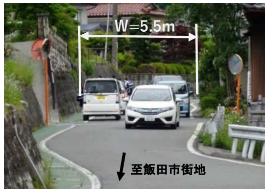
普通車のすれ違いが困難な状況
