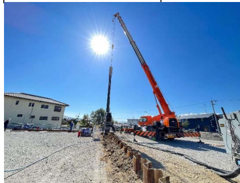
① 鋼矢板打込み
