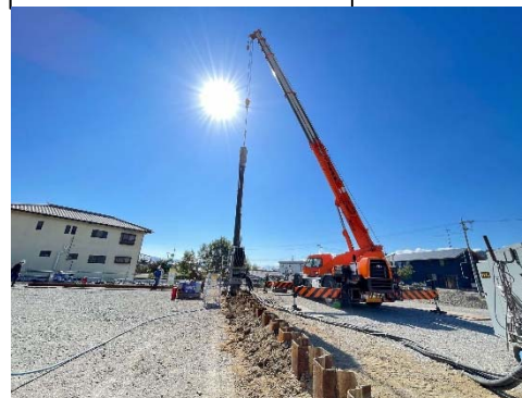
① 鋼矢板打込み
