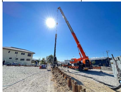
① 鋼矢板打込み
