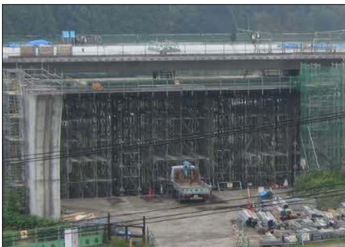
①固定式支保工
