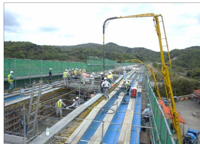
③上部工コンクリート打設
