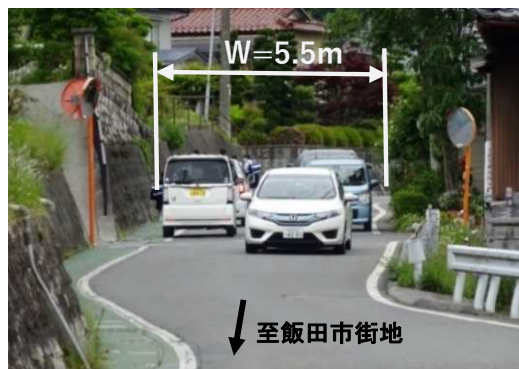
普通車のすれ違いが困難な状況
