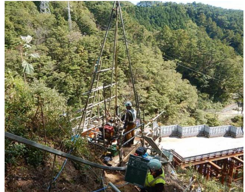
追加の地質調査の状況
