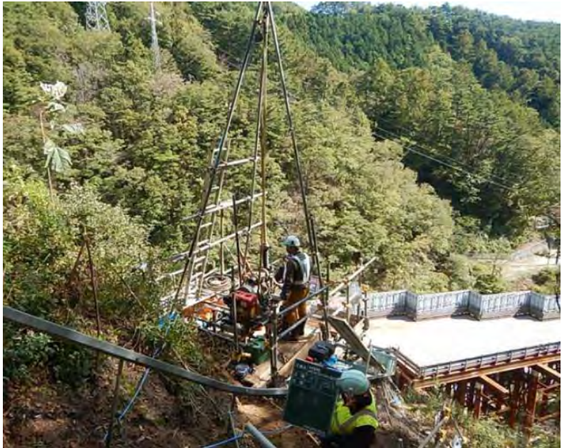
追加の地質調査の状況
