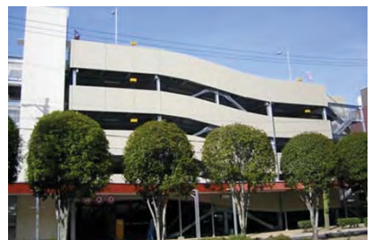
●拠点型駐車場
