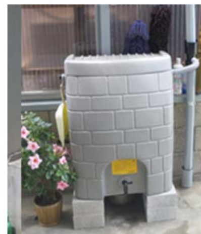
雨水貯留槽
