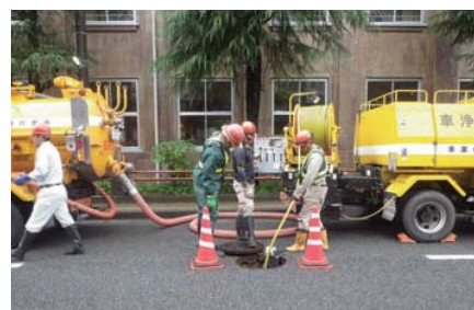
下水道管の清掃作業
