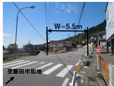
ガードレールによる歩車分離
