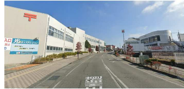
電線地中化が完了した箇所(県道)
