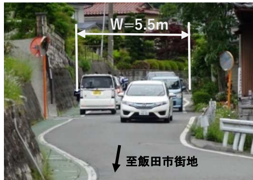
普通車のすれ違いが困難な状況
