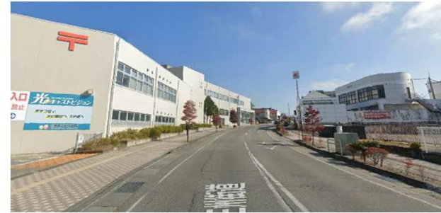
電線地中化が完了した箇所(県道)
