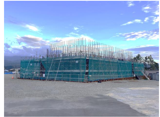
P1橋脚 施工状況
