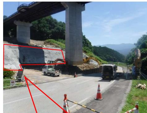
② P1・P2橋脚掘削時に湧水が確認され掘削面が崩れてきたため、安全確保のためモルタル吹付による仮設土留を施工したことによる増額。
