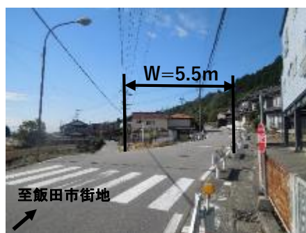
ガードレールによる歩車分離
