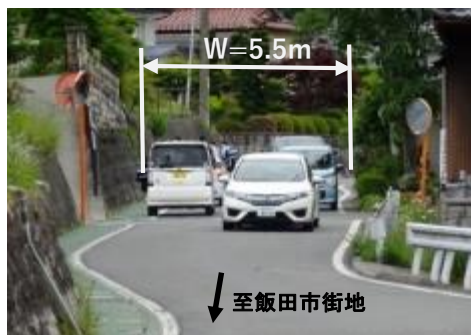
普通車のすれ違いが困難な状況
