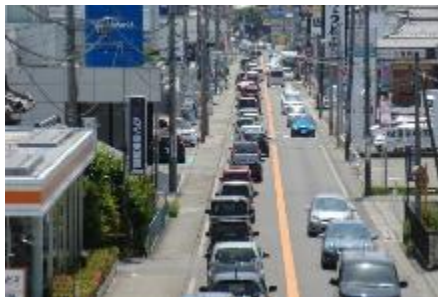
電柱・架空線の状況(国道整備前)
