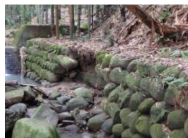
崩落した河川護岸
