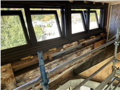
【動作不良の排煙窓と梁材の腐食（浴室）】
