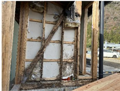
【外壁内部の腐食】
