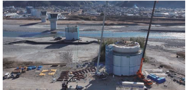
河川内で建設が進められている橋りょうの橋脚
