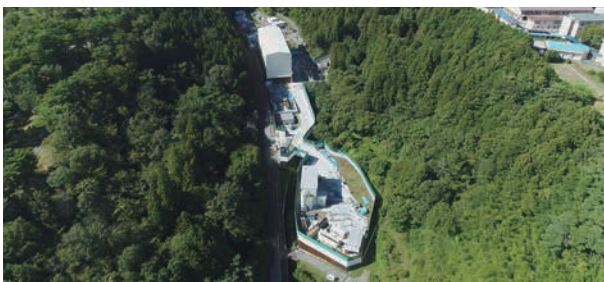
子どもの森公園の東に設けられている黒田工区工事ヤード
