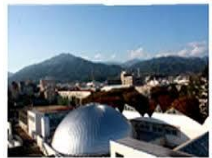
＜当館屋上のドーム＞
