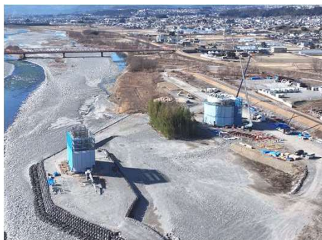
飯田市側橋脚躯体工事実施
