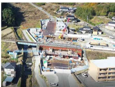
JR飯田線アンダーパス工事 函渠工事、盛土工事を実施
