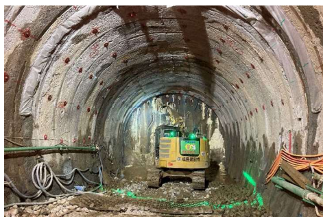
非常口トンネル掘削を実施
