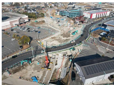
新戸川函渠工事を実施
