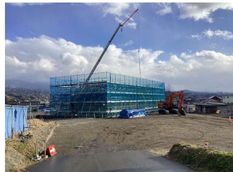
土曽川橋りょうの橋脚基礎工事を実施 令和6年11月 竜西一貫水路付替え工事完了
