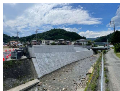
土曽川護岸工事(上郷側) 飯沼南地区軽量盛土工・擁壁等 拡幅工事を実施
