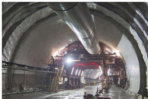
本線トンネル掘削を実施
