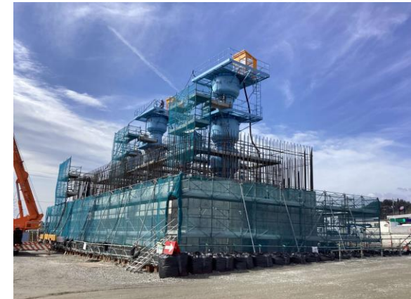
①P1橋脚 施工状況
