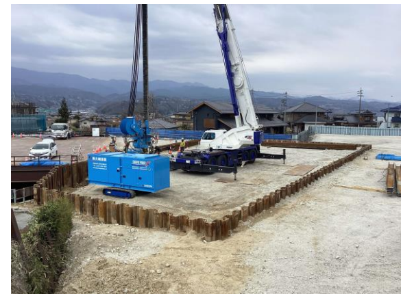
②P2橋脚 施工状況
