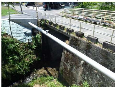
工事後（ステンレス鋼管 \phi 150\text{mm} ）
