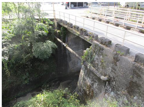
工事前（亜鉛メッキ鋼管 \phi 150\text{mm} ）
