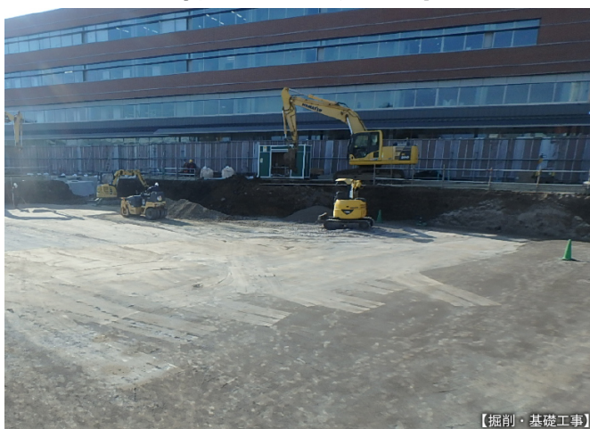
掘削・基礎工事
