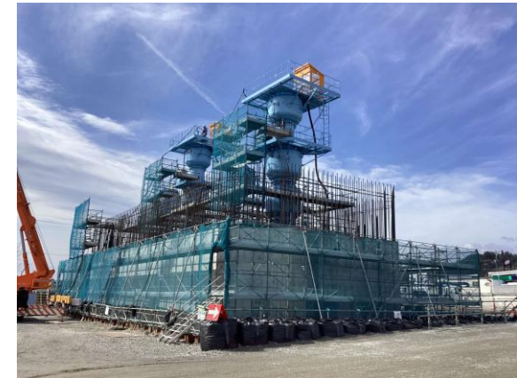
①P1橋脚 施工状況
