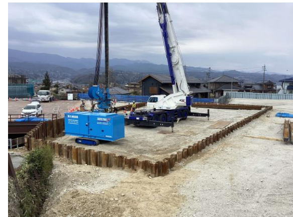
②P2橋脚 施工状況
